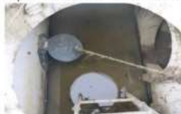
Clapet de confinement et orifice calibré
