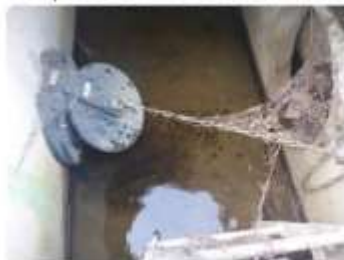
Clapet de confinement et orifice calibré
