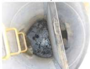
Orifice calibré sur paroi mince
